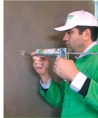
Uygulama tabancası ile deliğin içini 2/3 oranında dolduracak şekilde uygulanır.
