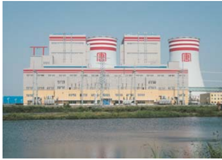
Harbin Elektrik Santrali, Çin
