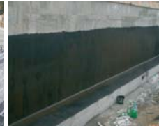
Perde duvar yalıtımında KÖSTER Deuxan 2K uygulaması
