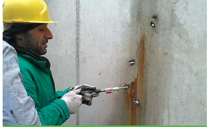
Betonarme perde duvarlara enjeksiyon uygulaması
