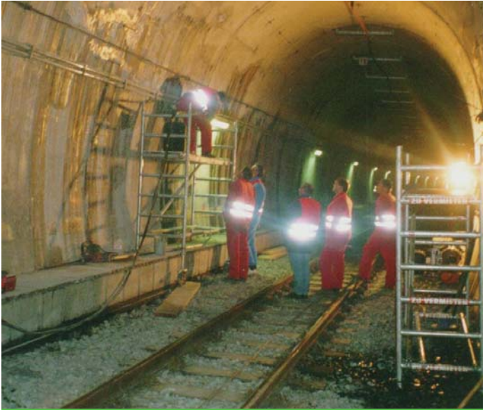
Tünel içinde beton çatlaklarına KÖSTER KB-Pox IN enjeksiyon işleminin uygulanması
