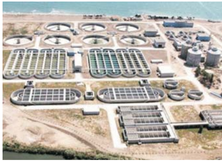
Karaduvar Atıksu Arıtma Tesisi, Mersin
