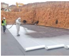
Püskürtme ekipmanı ile KÖSTER Deuxan 2K uygulaması
