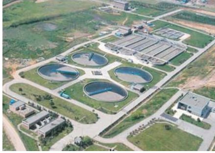
ISKI Paşaköy Arıtma Tesisi, İstanbul
