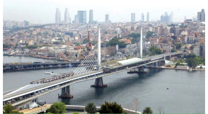
İstanbul Haliç Metro Köprüsü'nde KÖSTER Bond Paste RS kullanılmıştır.
