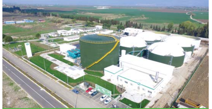
Bursa Sütüş Arıtma Tesisi'nde KÖSTER Yıldırım Tozu kullanılmıştır.
