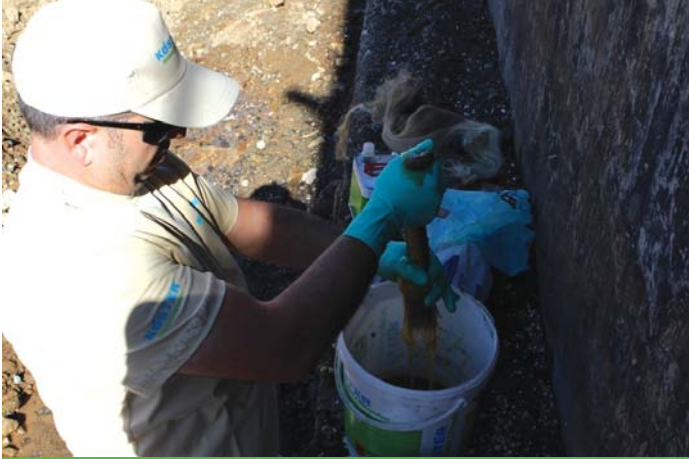
KÖSTER KB-Pur GEL hazırlanması
