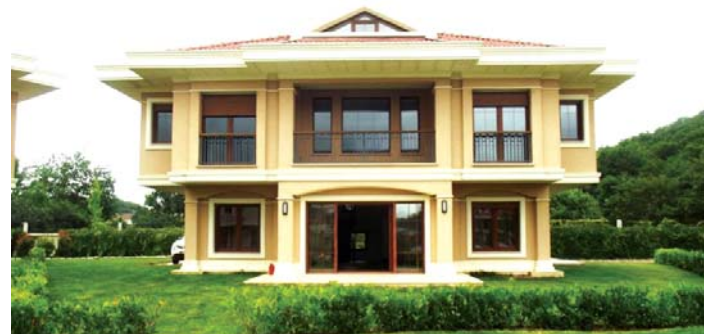
İstanbul Kemerburgaz Villaları'nda KÖSTER Siloxan kullanılmıştır.
