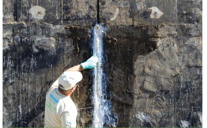
Trabzon Akçaabat Belediyesi İçme Suyu Deposu'nda KÖSTER KB-Pur GEL kullanılmıştır.
