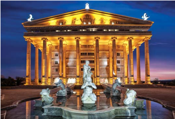
Kıbrıs Kaya Artemis Hotel'de KÖSTER Grout S 50 kullanılmıştır.
