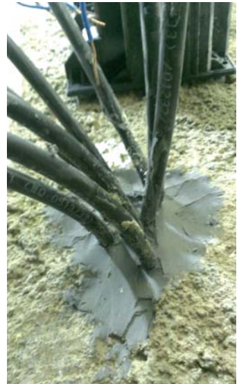
Kablo veya boru geçişi KÖSTER KB-Flex 200 kalıcı elastik macun ile doldurulur.
