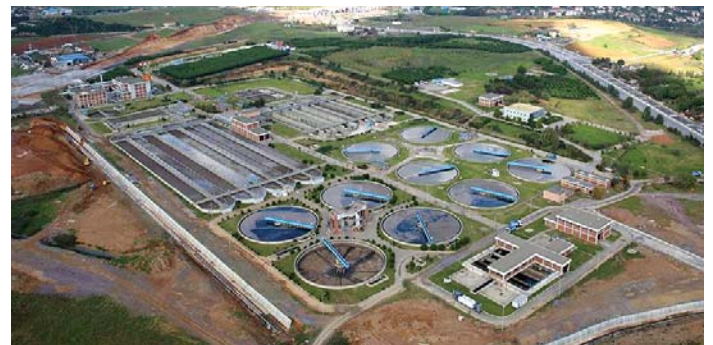
Istanbul ISKI Paşaköy Arıtma Tesisi'nde KÖSTER M.D.F. kullanılmıştır.
