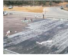
Karayollarında KÖSTER Deuxan 2K ile yalıtım uygulaması
